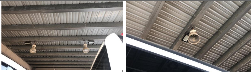
INSTALACION DE NUEVAS LAMPARAS LED EN HANGAR DE MANTENIMIENTO
