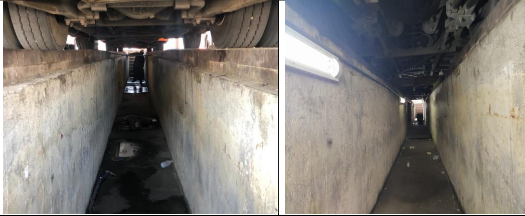
INSTALACION DE ILUMINACION DE CARCAMOS DE MANTENIMIENTO
